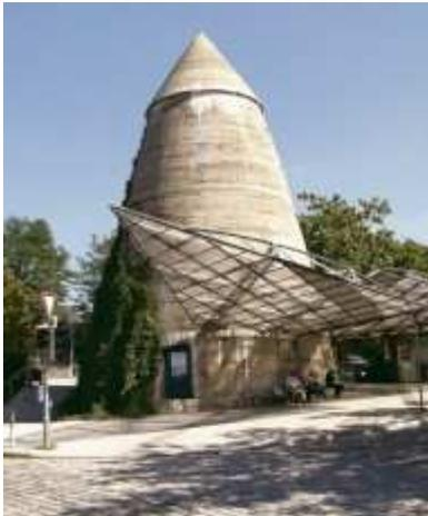
Ein Bauwerk von seltsamer Gestalt: Der Spitzbunker in Feuerbach ist eine Erfindung von Leo Winkel. Die Form sollte bestmöglichen Schutz vor Bomben bieten.
